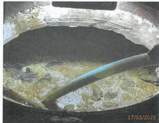
รูปที่ 16 การสูบน้ำส่วนเกินจากระบบบำบัด
