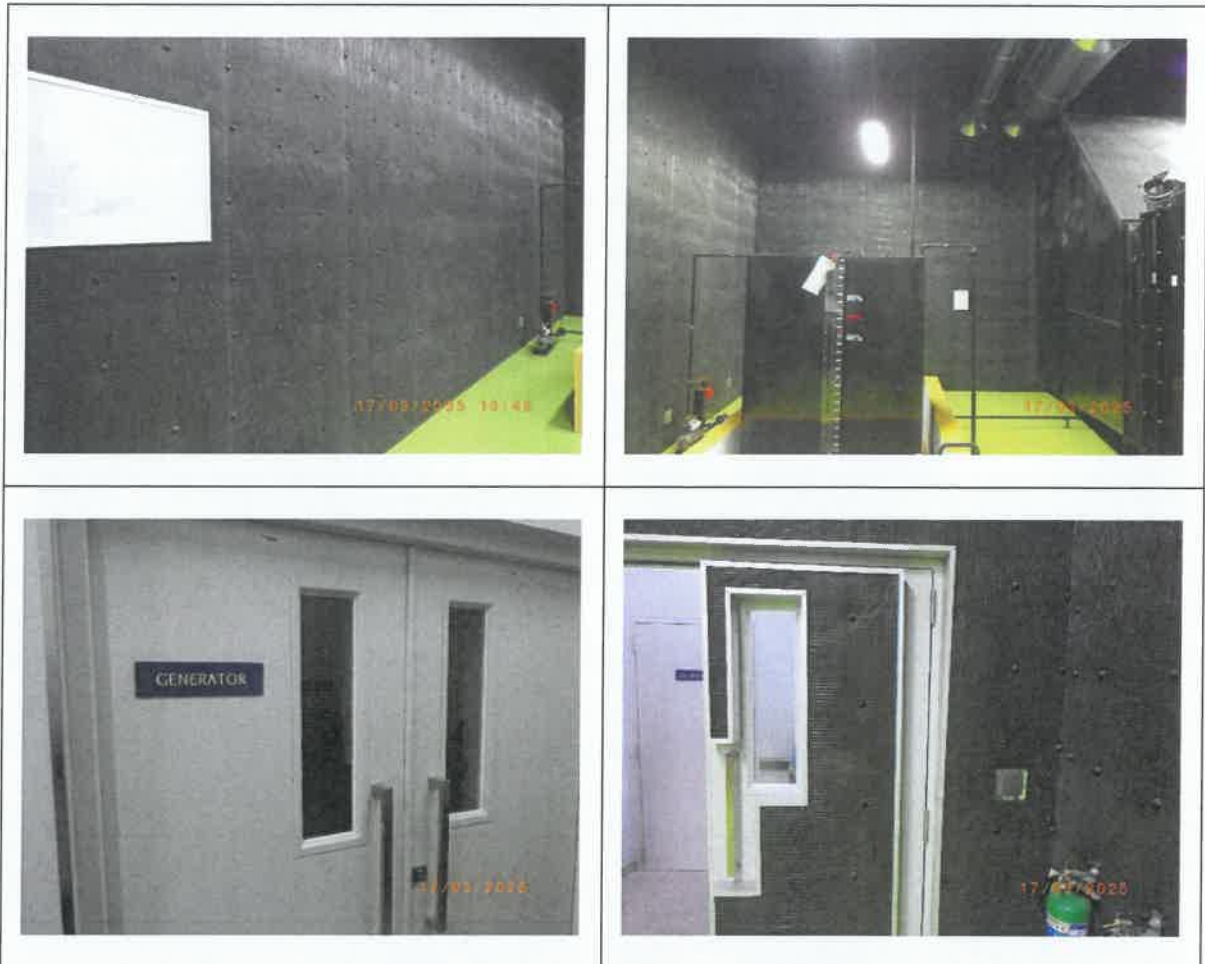
รูปที่ 48 ห้องเครื่องกำเนิดไฟฟ้าด้วยวัสดุกันเสียง
