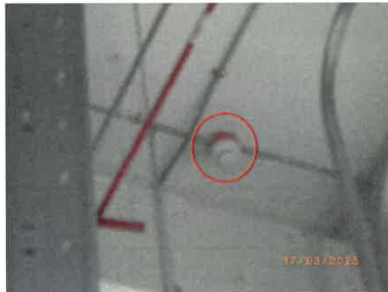
รูปที่ 46 เครื่องตรวจจับควัน (Smoke Detector) ภายในห้องหม้อแปลงไฟฟ้า
