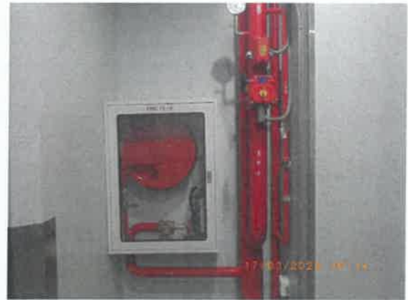
รูปที่ 53 ตู้เก็บสายฉีดน้ำดับเพลิงพร้อมอุปกรณ์ (FHC)
