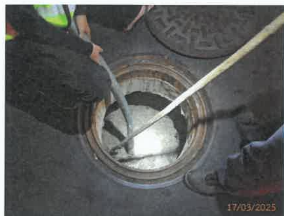
รูปที่ 17 การกำจัดไขมันออกจากปอดักไขมัน
