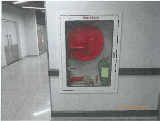
รูปที่ 53 ตู้เก็บสายฉีดน้ำดับเพลิงพร้อมอุปกรณ์ (FHC)
