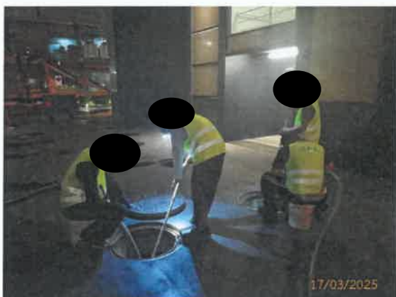
รูปที่ 17 การกำจัดไขมันออกจากปอดักไขมัน
